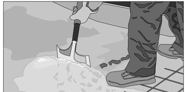
Revisar constantemente los niveles, para que no queden zonas disperejas o que sobresalgan del nivel en que se debe terminar el radier. Para esto, usar una lienza o nivel láser entre los extremos, así se tendrá en mente el nivel del piso terminado.
