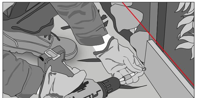
Fijar las tablas a las estacas con tornillos y si es necesario agregar algunas extras para sostener el marco.
